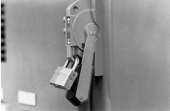
*Mettez la machine hors tension et bloquez l'accès aux commandes.*
